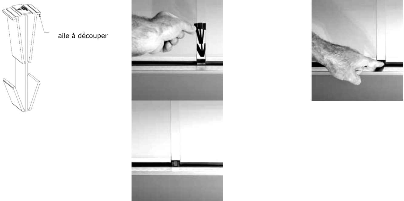
Figure 9 – Joint sapin pour boucher l'espace entre plaques de verre
